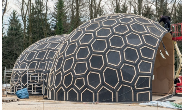
Von oben links im Uhrzeigersinn: Aufbau und Verschrauben der Schale; Detail der Plattenerbindung in der Innenansicht; Fertige Schale mit Dämmung und wasserführender Schicht.
